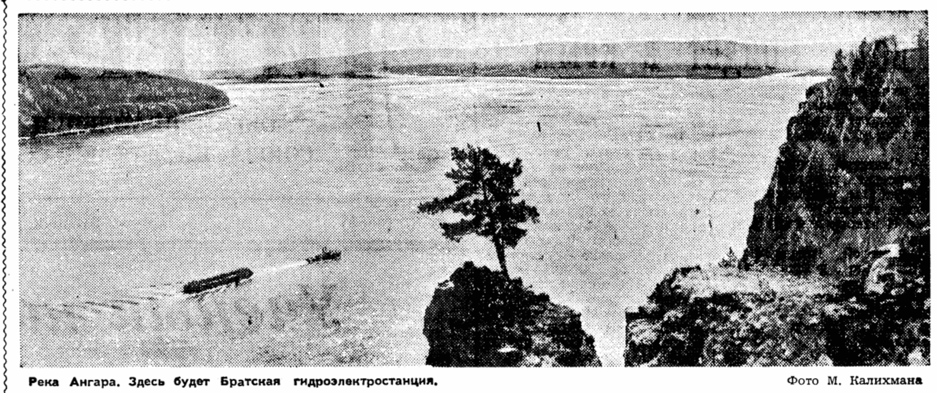
Река Ангара. Здесь будет Братская гидроэлектростанция. Фото М. Калининана
